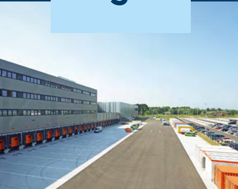
Entrepôt Zalando - Lahr (Allemagne)
