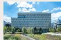
Le Coruscant Saint Denis (93) 2 217 m 2
